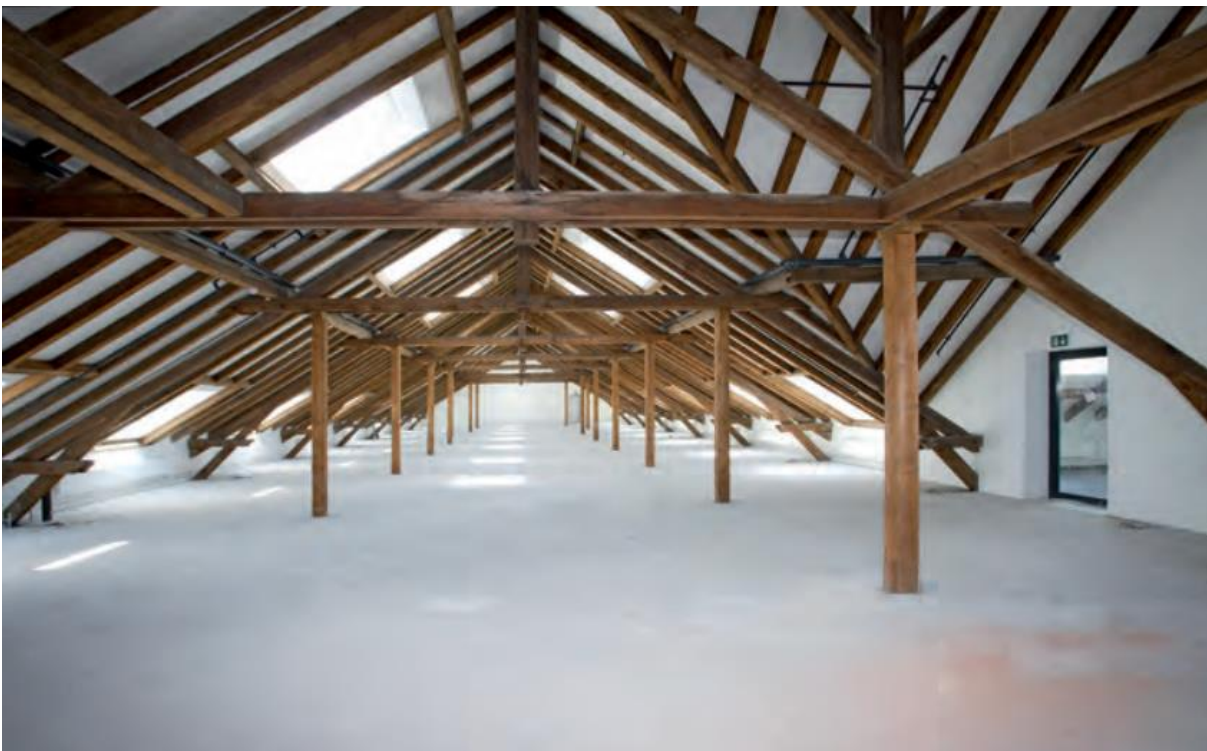
Bild 5: Urbane Wohnraumgewinnung durch Sanierung eines Trockenspeichers [4]
