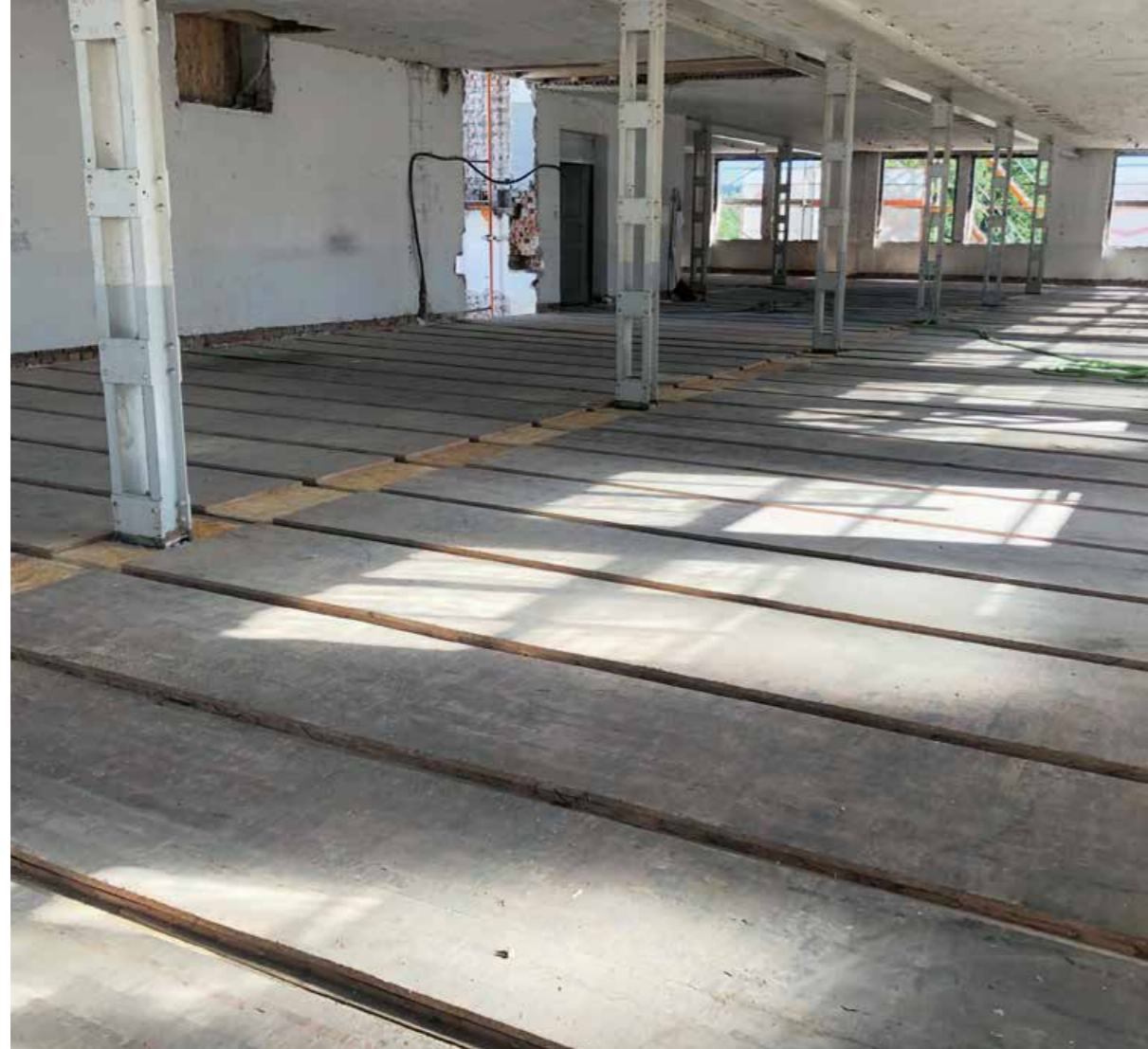
► Im Zuge der Sanierung durfte die Schalung des Bestandsbodens bleiben
