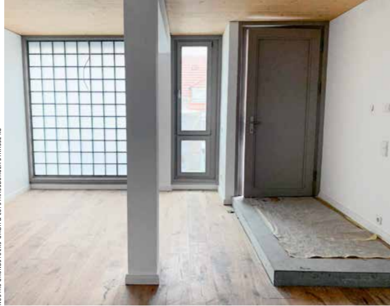
▲ Die Decken sind in Sichtholzqualität ausgeführt. Die Böden setzen auf einen Belag aus Holzdielen
