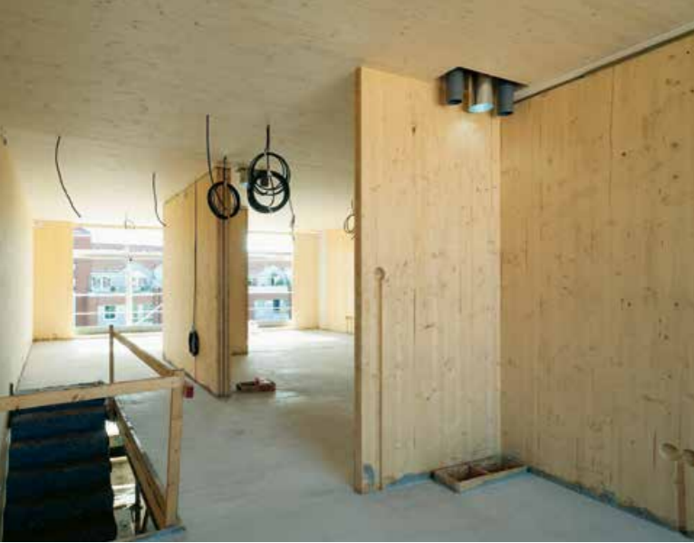
▲ Die Wände stehen, das HBV-System ist bereits fertiggestellt. Jetzt kann der Innenausbau beginnen
