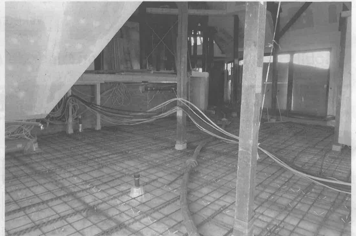
Zum Einsatz kam ein Holz-Beton-Verbundsystem von Elascor.
