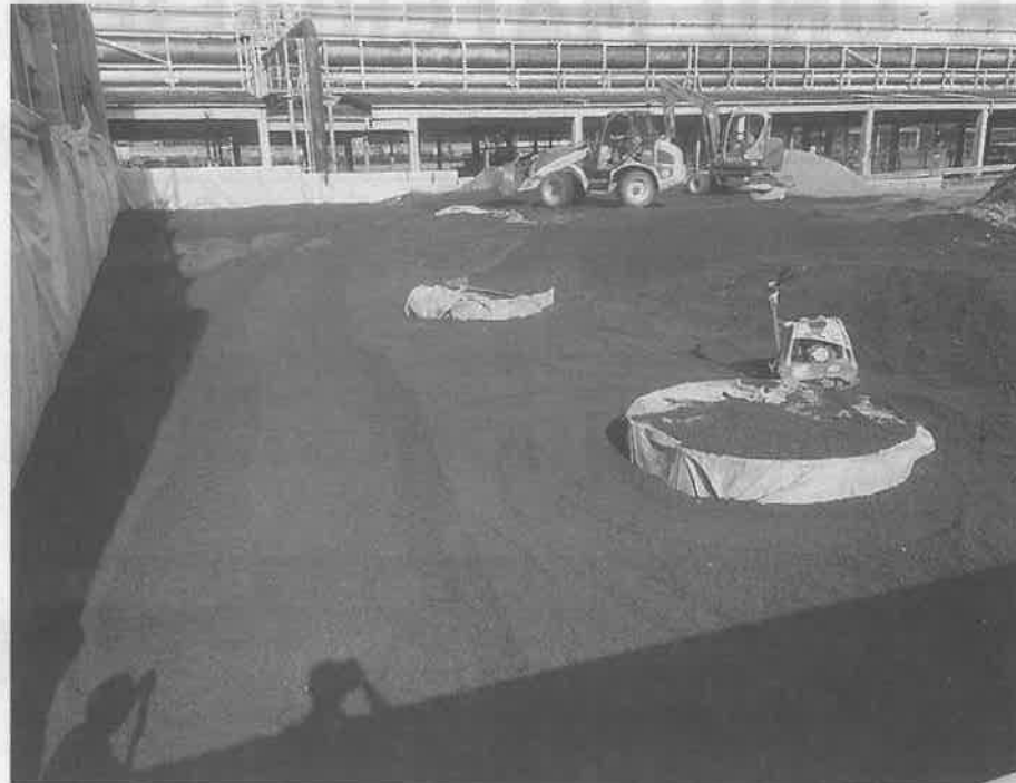
Für das Projekt wurde 460 m 3 HansePor-Blähton argex je zur Hälfte in den Stärken 4-10 R und 8-16 R gemischt angeliefert und auf den Kanal geschüttet.
