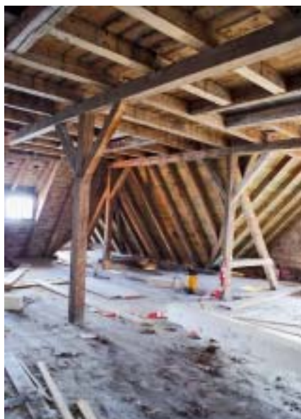
Das 4. OG noch im unsanierten Zustand.
