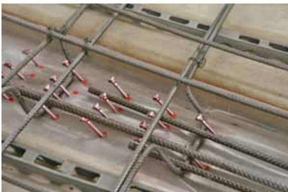
Rechts: Die Gurte des Spannsystems wurden von temporären Gitterträgern abgehängt
