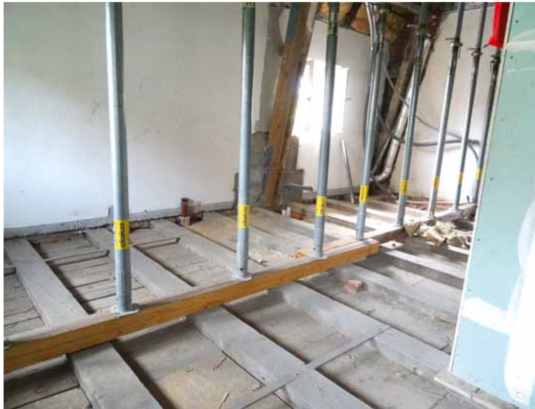
Freigelegte Deckenbalken und Gefachbereiche mit Fehlboden zur möglichen Ausführung des HBV-Systems
